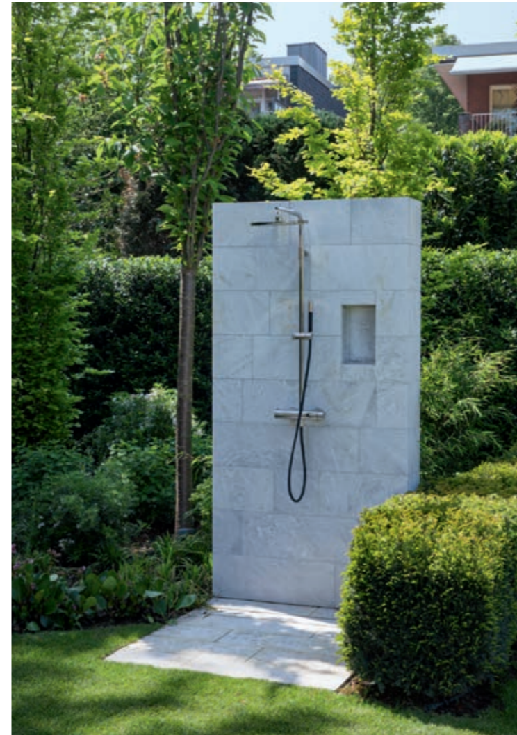
Passend zum edlen Stil von Villa und Schwimmbecken wurde auch die Außendusche gestaltet. Die Duschwand harmonisiert mit den Poolmaterialien und gibt zugleich Sichtschutz.
